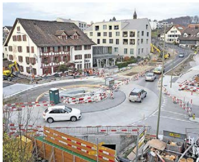
Zur Hälfte fertig präsentiert sich der neue Zentrumskreis vor dem Gasthof Bären in Nürensdorf. Nun rollt der Verkehr über die rechte Kreiselhälfte auch wieder durchs Zentrum in Richtung Lindau und in die Quartiere. owü
