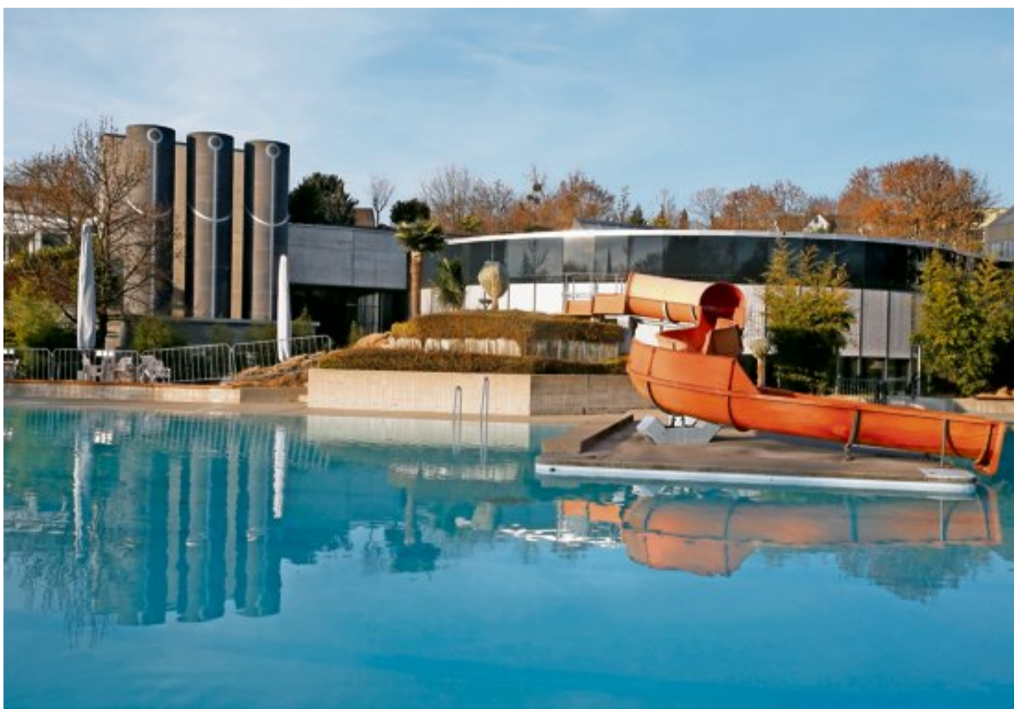
Aus der Luft, die vom Hallenbad durch die drei Kamine nach aussen gelangt, kann in Zukunft Wärme zurückgewonnen werden.
