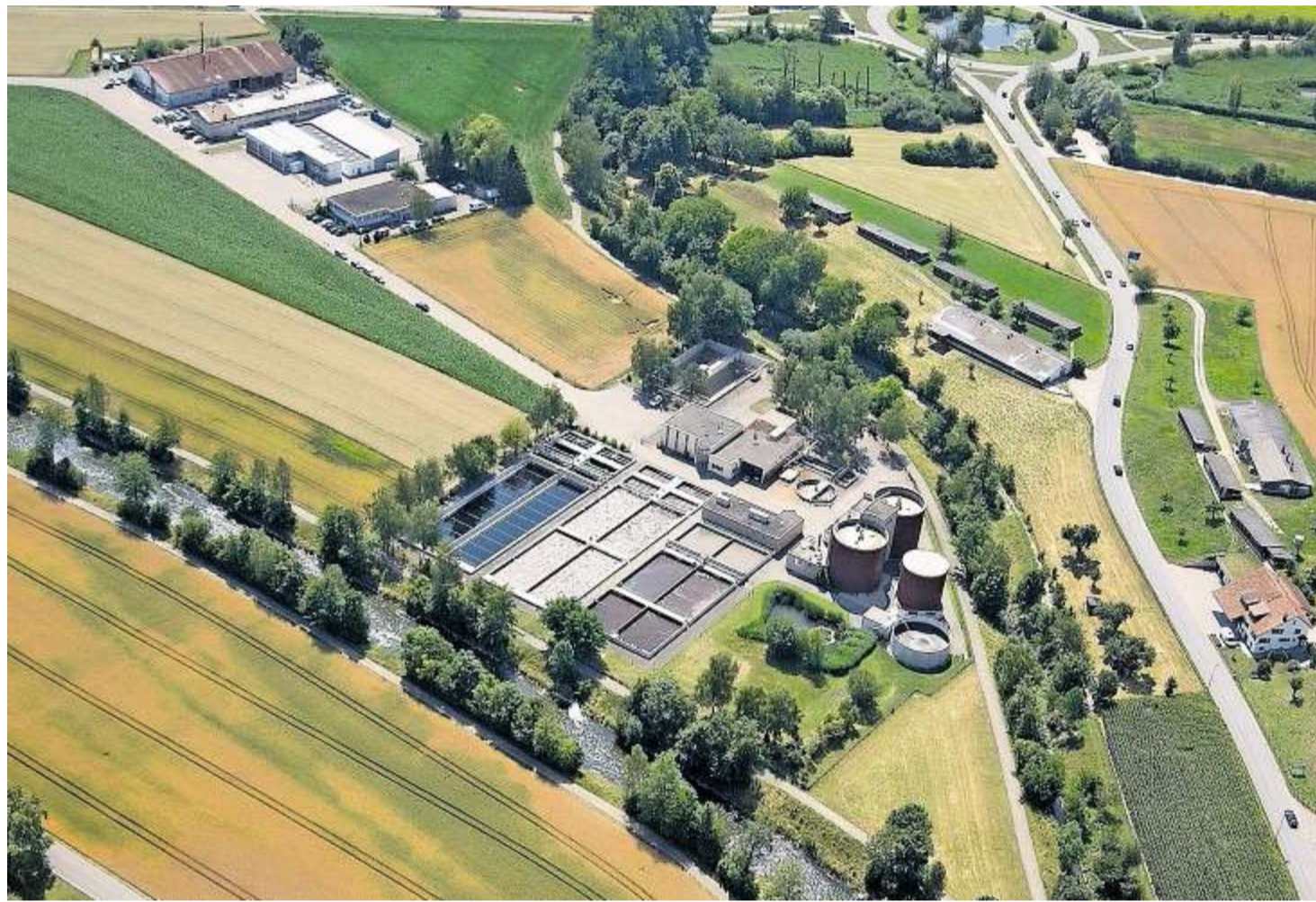
Die Abwasserreinigungsanlage (ARA) Fischbach-Glatt in Niederglatt kann für 61 Millionen Franken saniert und ausgebaut werden. Danach soll die 1972 eröffnete Anlage die Bedürfnisse und die aktuellen Auflagen erfüllen und 20 Prozent mehr Abwasser bewältigen können.
